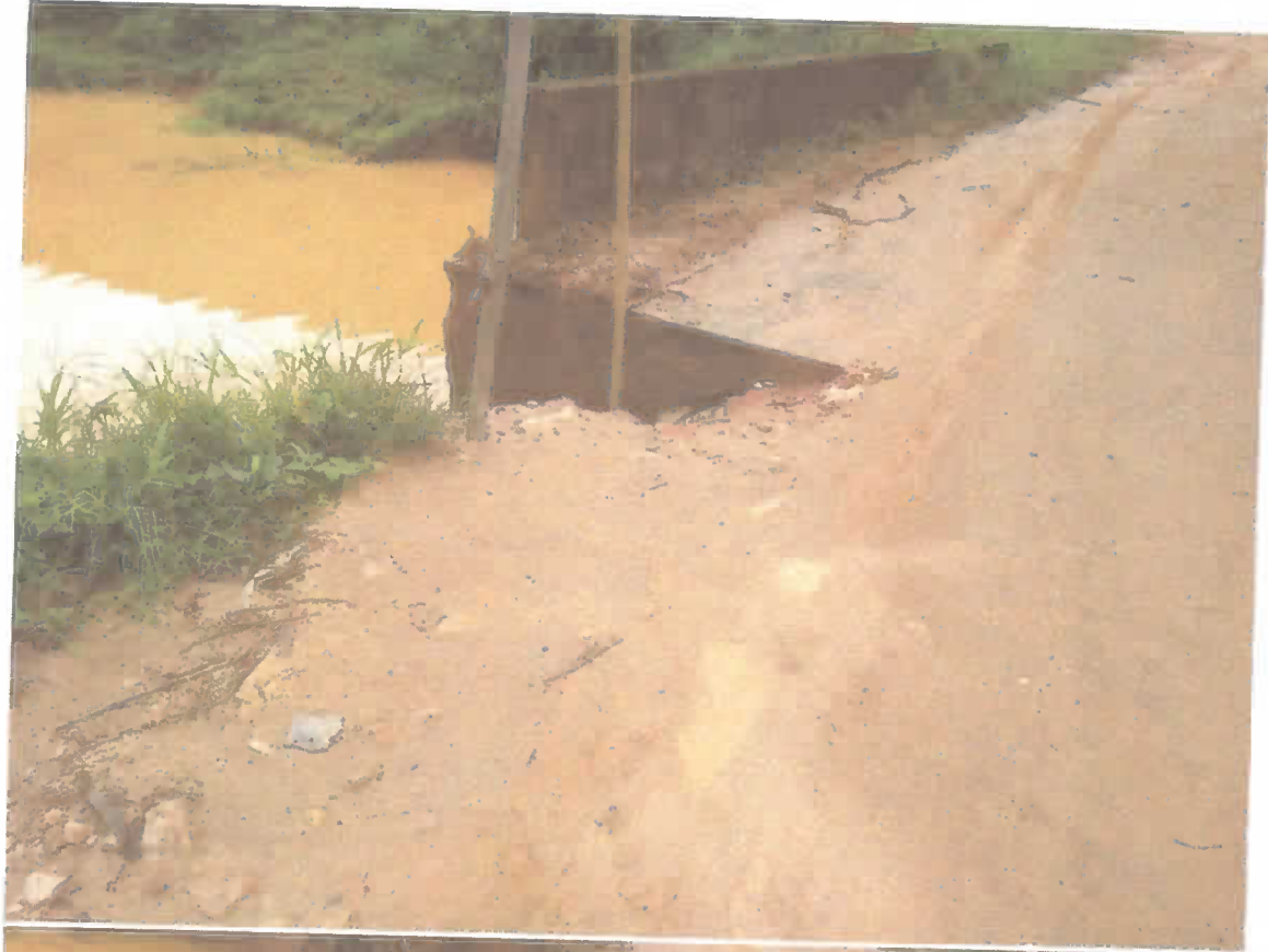
PONTE DA ESTRADA DO PATRIMÔNIO DOS CARNEIROS
